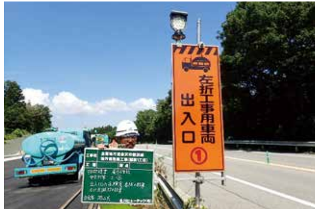
〈工事用車両出入りロゲート番号表示〉
