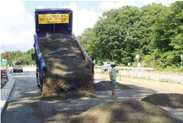
〈工事用車両注意喚起後段幕〉
