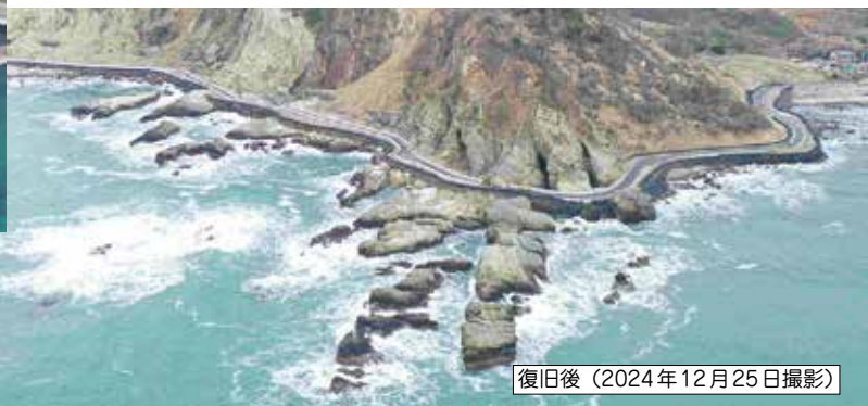
国道249号逢坂トンネル工区（珠洲市）
