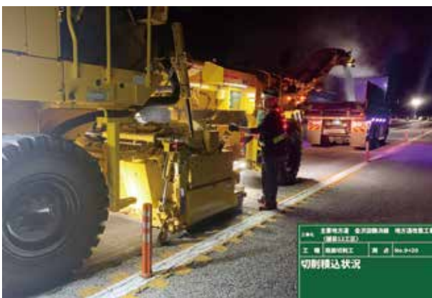
夜間急速施工での現道部との擦り付け
