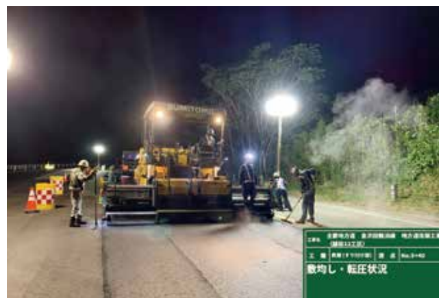
夜間急速施工での現道部との擦り付け
