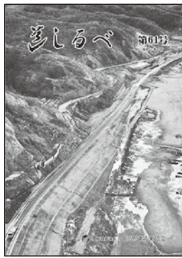
写真：国道249号 大川浜工区〔輪島市町野町大川～浜田町〕緊急復旧道路（2024.12.20撮影） （写真提供：国土交通省 北陸地方整備局 能登復興事務所）
