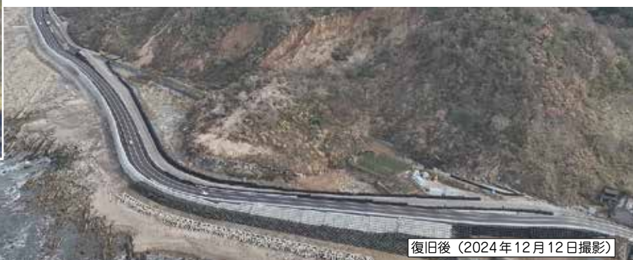
国道249号千枚田工区（輪島市）
