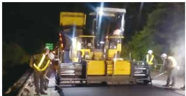
工事着手前舗装（レベリング）
