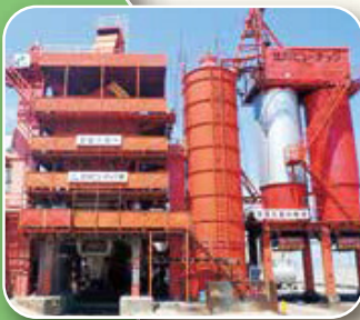
北川ヒューテック(株) 手取合材所 (120t/h)
